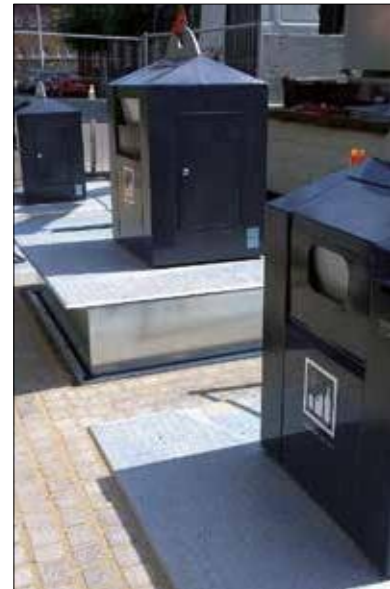
Project Horsens fl015 (Denemarken), oplevering van 300 Classic ondergrondse containers.
