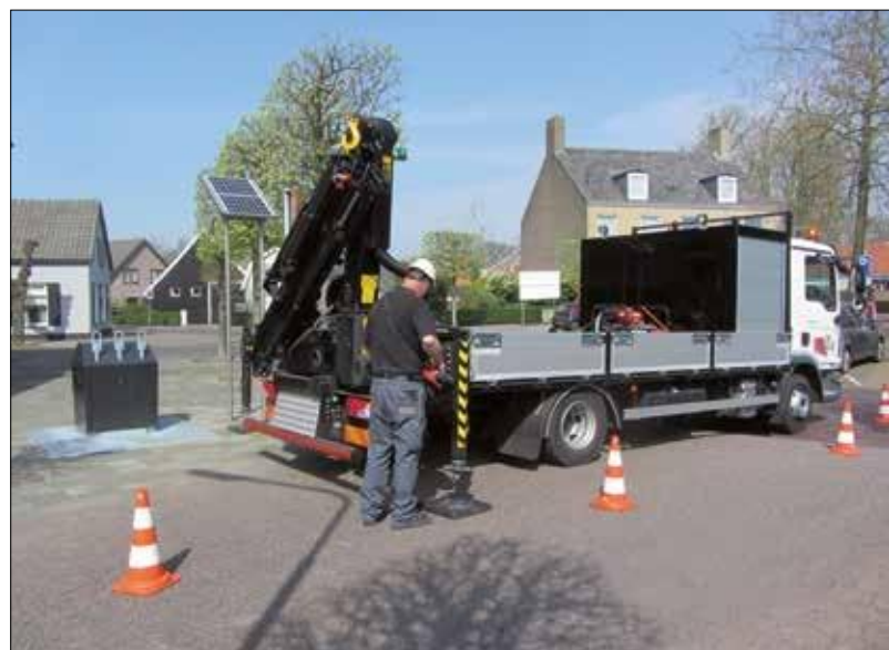
Locatie veilig gesteld. Werkzaamheden kunnen beginnen!
