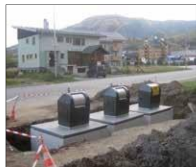
De zuilen zijn te (de)monteren met slechts 3 bouten.
