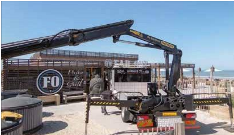
Onderhoudswerkzaamheden in Zandvoort.
