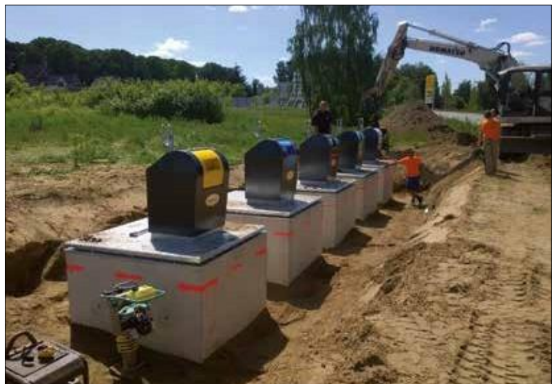
Containerparkje tijdens plaatsing in Selmsdorf, Duitsland.
