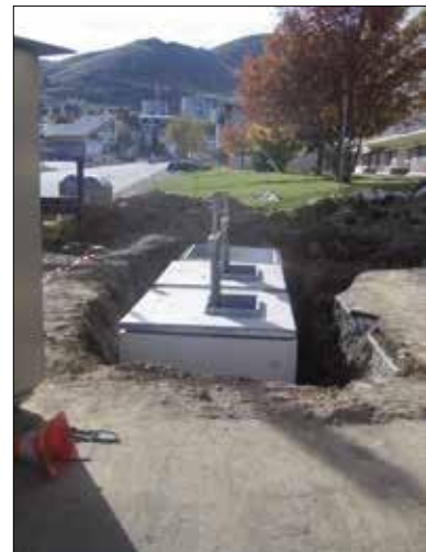
Een lokale aannemer kan de containers plaatsen.
