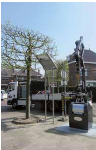
Service aan Solar perscontainer.
