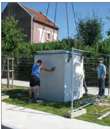
De betonsilo wordt in de voorbereide bouwput geplaatst.
