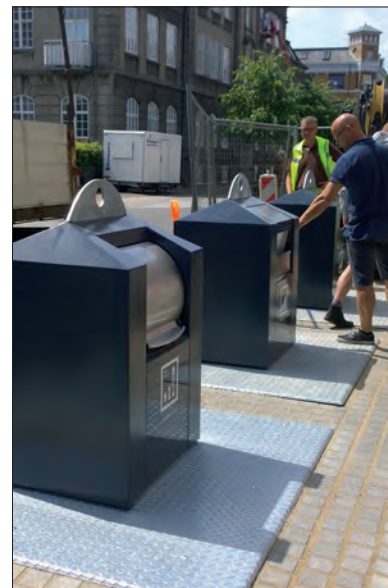
Classic ondergrondse containers met 80 liter trommel en diverse fracties.
